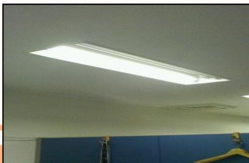
写真 V-2-1 ダミー管による蛍光灯数の削減(節電対策)
